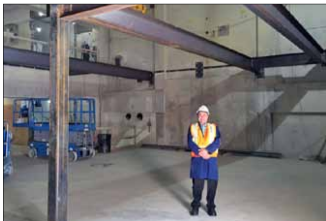
Steelwork for NEL Floors
