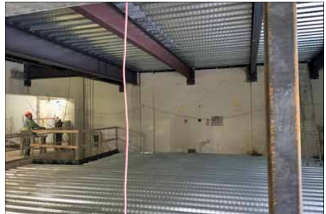
Constructing floors in NEL
