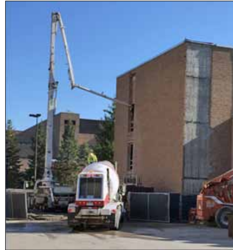
Pumping concrete into NEL
