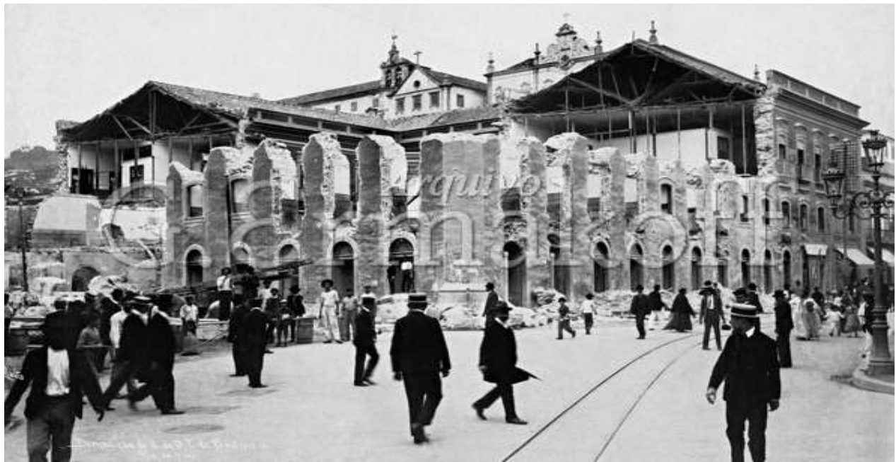
(Image 3.8 – The demolition of the São Francisco da Penitência hospital at the Largo da Carioca. Photograph by Augusto Malta, 1906. Available at http://www.ermakoff.com.br/ )
