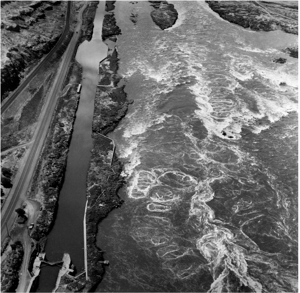
The Dalles-Celilo Canal. 1951.
