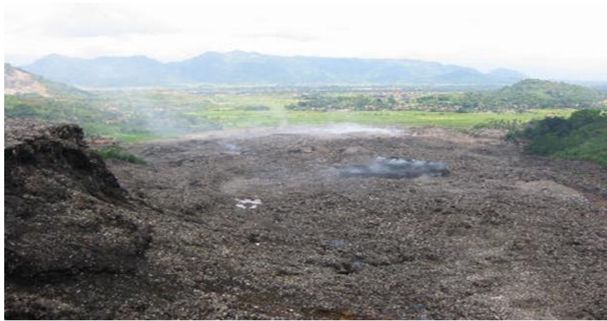
Figure 1.2 Leuwi Gajah Landfill failure (Koelsh et al. 2005).
