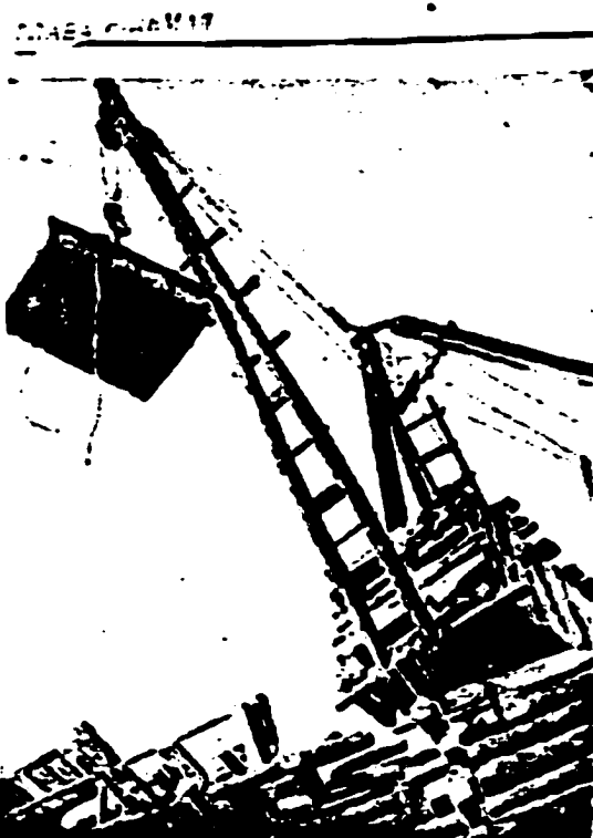
Основной герой Беломорской механизации — деревянный бэрри. Металлические части его конструкции сделаны целиком на самом строительстве
