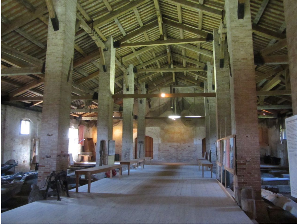
Figure 3.38: Interior of tezon grande , Lazzaretto Nuovo
