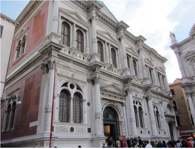
Fig. 7 Façade of the Scuola Grande di San Rocco (photo: author)
