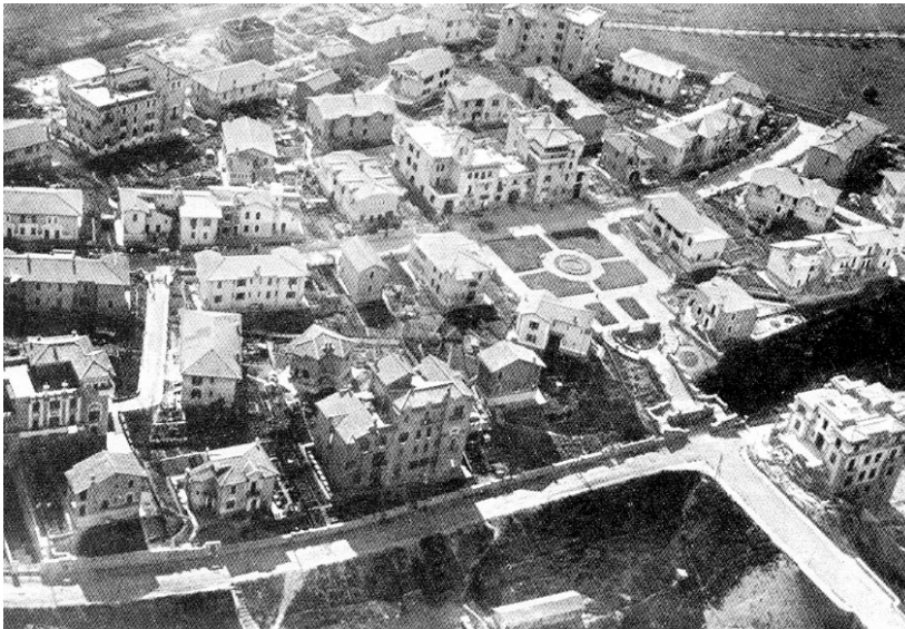
Figure 66. Aerial photograph of the first nucleus of the Garbatella, Rome, from Italo Insolera, Roma moderna: un secolo di storia urbanistica, 1870-1970 .
