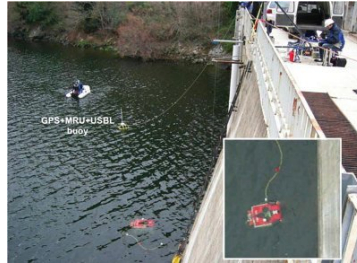
(d) Dam inspection
