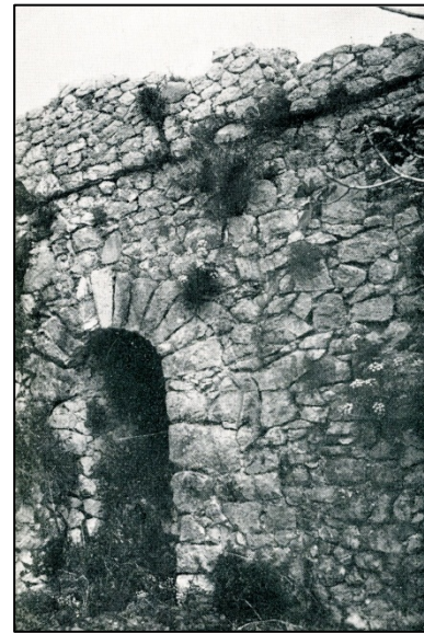
Figure 5. Example of “Prima Maniera” facing from Tarracina (Lugli 1957).
