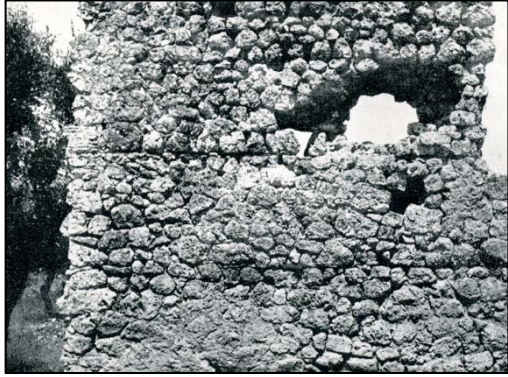
Figure 6. Example of “Seconda Maniera” facing from Cosa (after Lugli 1957).
