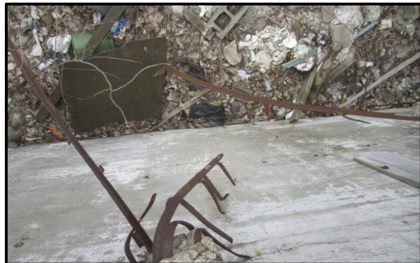
Figure 24. The Kahn Bar in situ.
