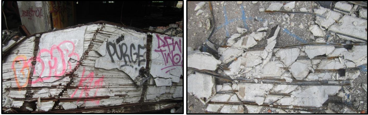
Figure 26. Hy-Rib in situ.
